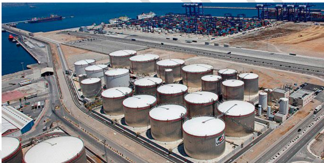
Figura 4. Instalaciones de almacenamiento de EVOS en el Puerto de Bahía de Algeciras
