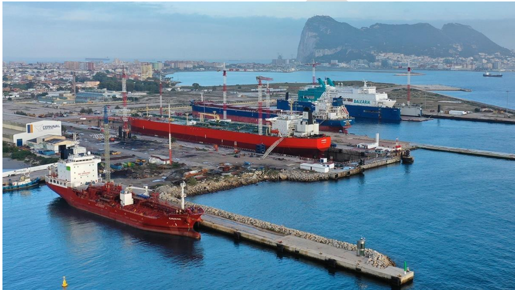
Figura 3. Instalaciones de CERNAVAL en el área de Campamento del Puerto de Bahía de Algeciras
