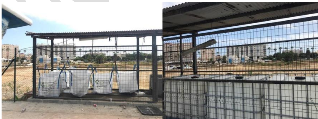
Figura 21. Instalaciones de recepción de desechos en el área de varadero de Alcaidesa Marina
