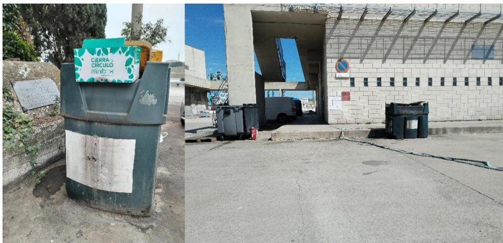
Figura 18. Instalaciones de recepción de desechos en la Dársena de Embarcaciones Auxiliares y Dársena Pesquera
